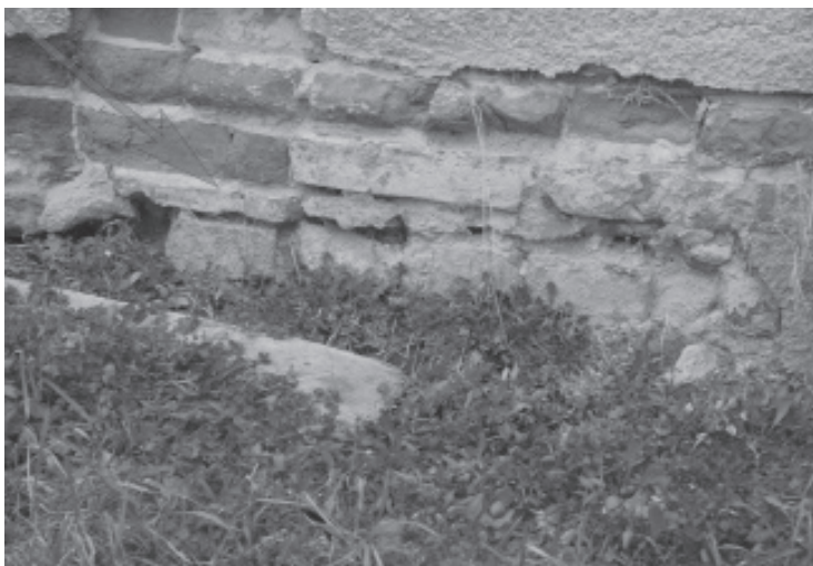
7. kép. A 18. századi barokk téglasorok kiegyenlítésére használt, másodlagosan beépített lapos török téglák a kápolna szentélyének déli falában (Szerző felvétele)
