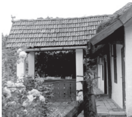
4. kép. A bajomi ház korábban fa ágasos „kiugró”-ja már téglapilléres- deszka-mellvédes. Keleti oldalán díszövény : vadszőlő. Fedelén, a szélső kúpcserépen fazekas készített kakas áll, tűzvész-elhárító néphit -elemként. (Bellon Tibor 1973, Györffy István Nagykun Múzeum ltsz. 3856)
